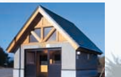
●周辺東浜佐呂間線駐車場公園 トイレ
