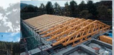
●茶路小中学校校舎改築 屋根トラス組み立て状況
