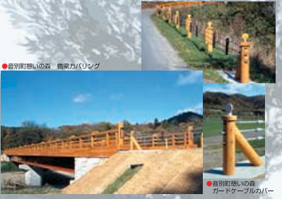
●豊別町豊いの森 橋梁カバリング
