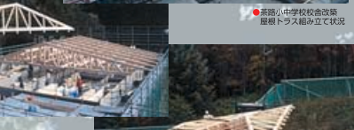
●茶路小中学校校舎改築 屋根トラス組み立て状況
