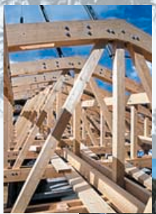
●茶路小中学校校舎改築 屋根トラス組み立て状況
