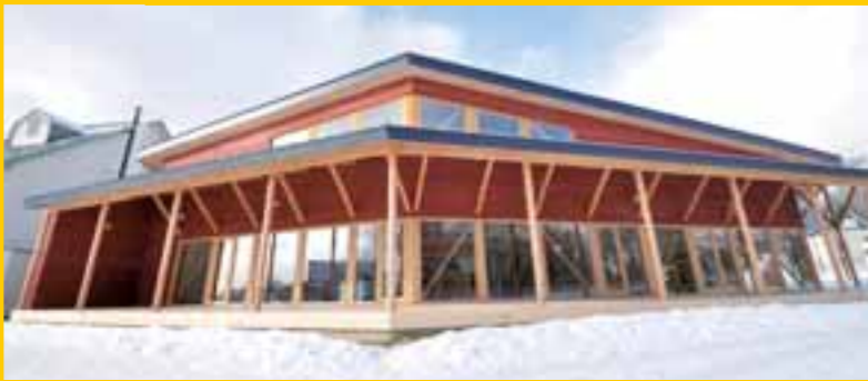
雄島寺木崩 (釧路市)
