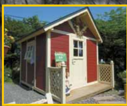
カントリードールアトリエ (白糠町)
