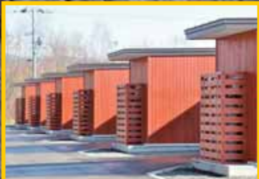
公営住宅プロパン庫 (弟子屈町)
