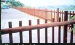
●釧路市 春採公園ウッドボールフェンス
