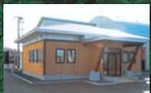
●釧路市 トーホー工業網走事務所
