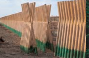
●浜中町 湯涌防風堤
